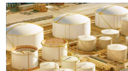
Petrochemische Anlagen in Spanien
